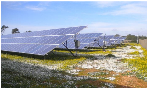
1.8 MW-Anlage Digrun in Lluçmajor auf Mallorca
